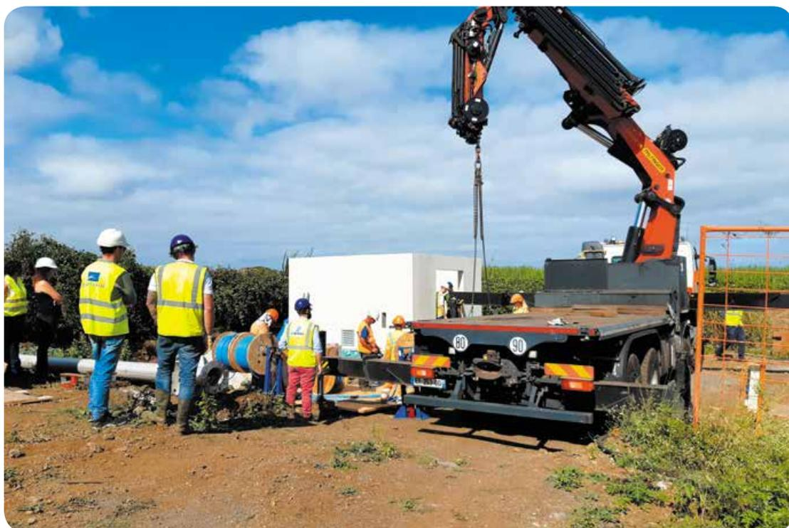
Travaux de pose de la colonne d'exhaure DN 200
