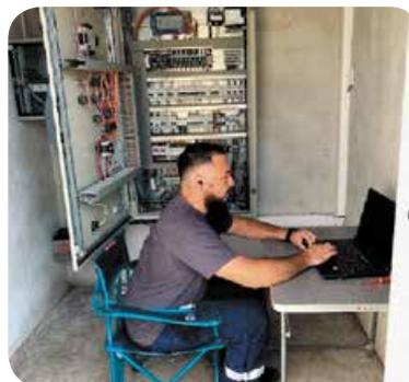
Raccordements électriques en chambre de vanne enterrée et programmation de l'automate de pilotage de la vanne.
