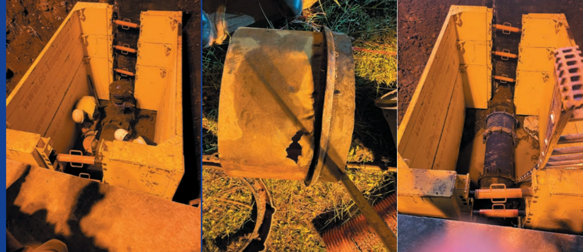
Réparation sur canalisation DN500 sur le réseau de l'Antenne O, en travaux de nuit le 14 avril.
