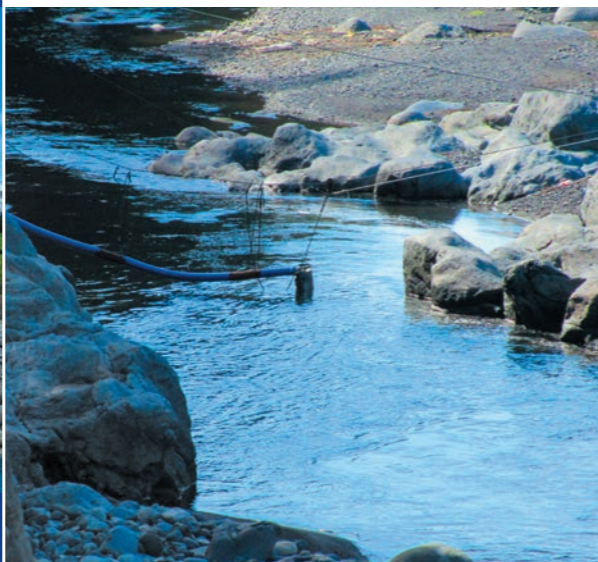
Site de pompage du périmètre irrigué de Champ-Borne.
