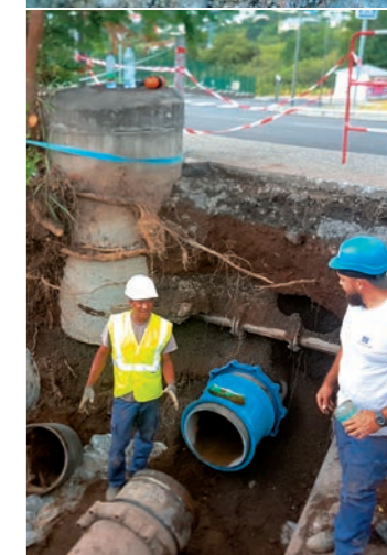
Réparation sur canalisation DN500 sur le réseau de l'antenne O en travaux de jour le 16 juin.
